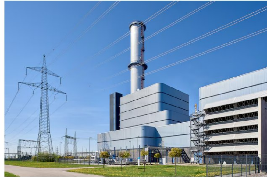
Gas- und Dampfturbinenkraftwerk Irsching
